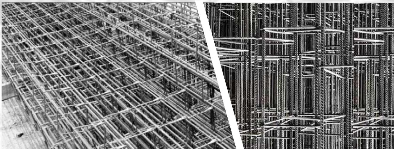
El castillo armacero es una armadura compuesta de alambres longitudinales y transversales unidos por soldadura mediante resistencia. Suele usarse como acero de refuerzo en traveses y columnas.
